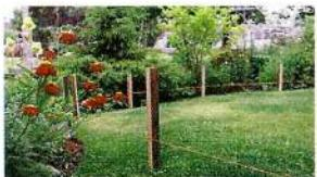
В первую очередь подготавливается основание для укладки тротуарной плитки, снимается старое покрытие если есть и вынимается дерн на 15 см.
